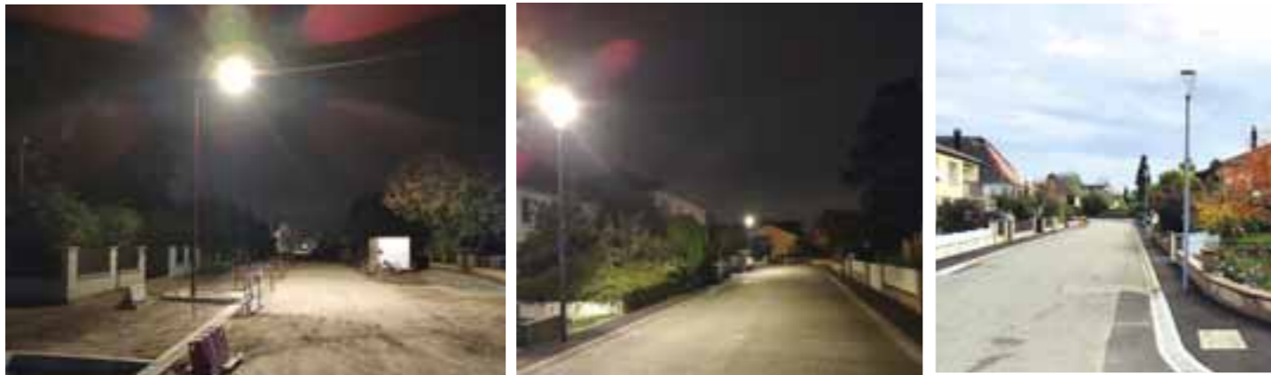
Remplacement des mâts et des luminaires dans nos quartiers
