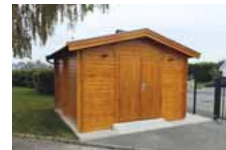
Montage et mise en lasure du chalet de stockage
