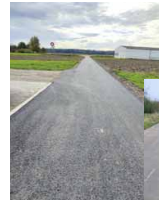
Réfection du chemin du Turnweg
