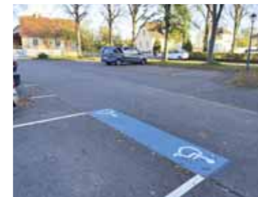
Reprise du tracé des cases des stationnement à l'Eglise Sainte-Thérèse
