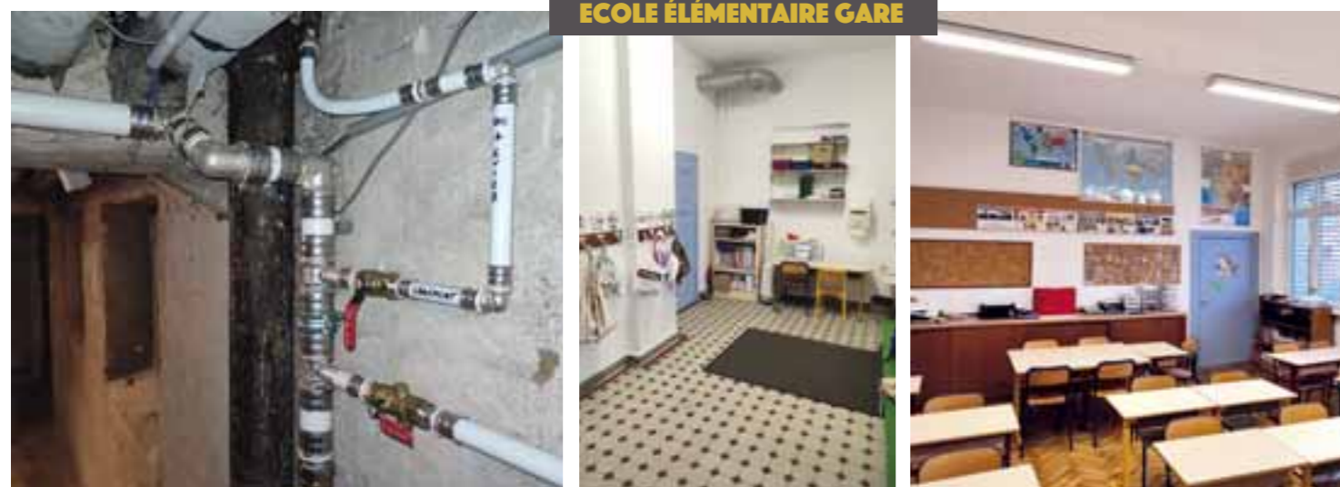
Renouvellement du réseau d'eau potable
