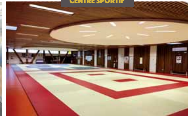
Remplacement des luminaires par des leds
