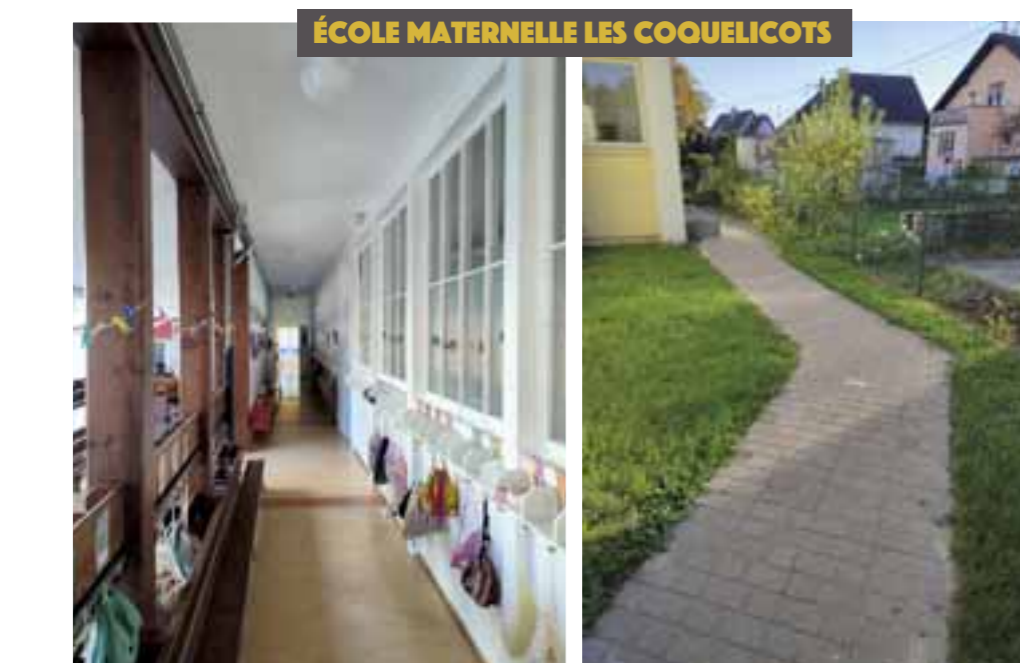
Remise en peinture
